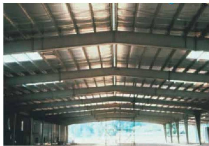
Soluția este destinată izolării acoperișurilor metalice ale construcțiilor industriale ce prezintă un nivel mediu de umiditate. Acest sistem izolator este format din folie de vată de sticlă și un înveliș protector care asigură atât aspectul final al substratului izolator, cât și rolul de barieră de vaporii.
