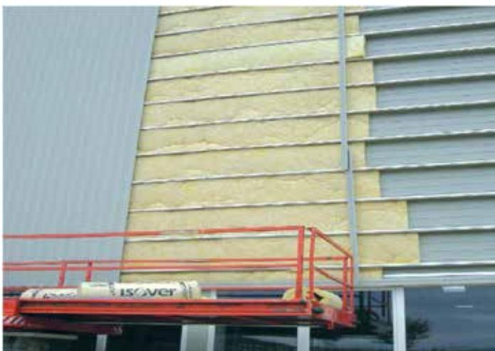
În foarte multe cazuri pereții laterali ai halelor metalice sunt realizati din casete metalice. Instalarea în aceste casete a produselor din vată minerală de sticlă asigură foarte bune performanțe termo și fonoizolante precum și un înalt nivel de siguranță față de incendiu. Pentru această aplicație se poate utiliza unul dintre produsele Isover KB sau Isover Piano.
