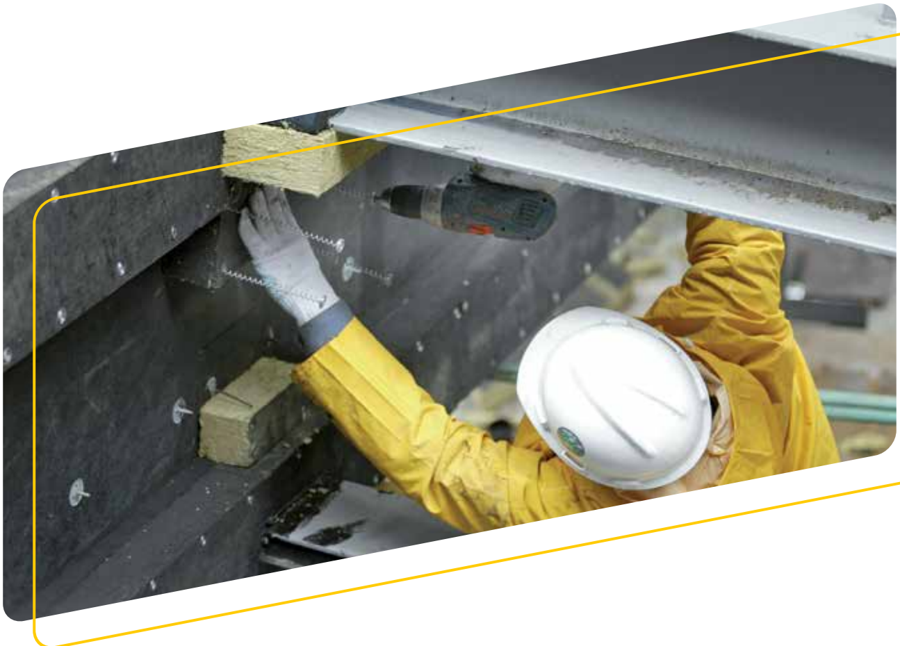
Fig. 4 Fixarea Isover FireProtect* cu știfturi (pini)
