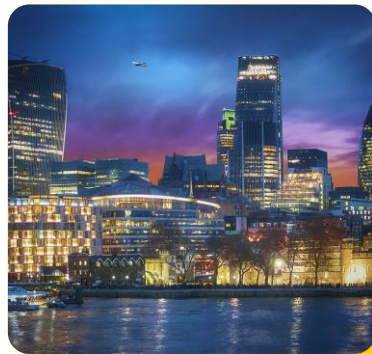
CLĂDIRI NOI / COMERCIAL
