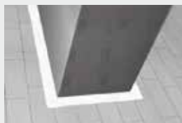
Strat de acoperire cu vopsea intumescentă
