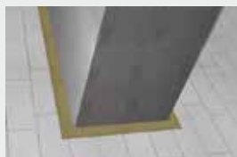
Vată minerală comprimată în spațiul liber
