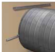
Fixarea conductei de structura de susținere
