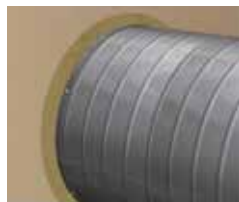
Vată minerală comprimată în spațiul liber
