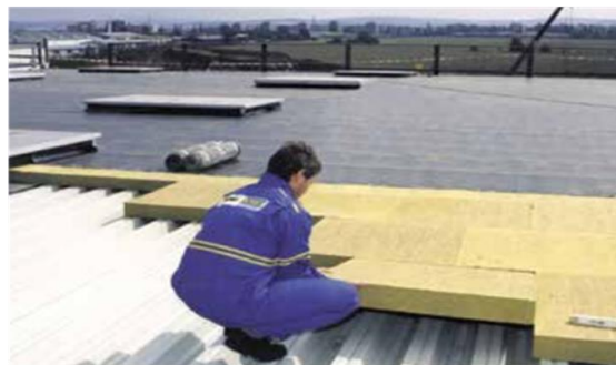
Montati placile de vata minerala cu lungimea perpendicular pe profilele trapezoidale
