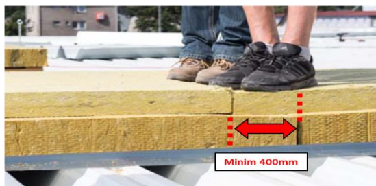
Decalati imbinarile straturilor de vata cu minim 400mm
