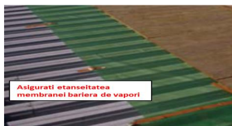
Montati membrane bariera de vapori etans
