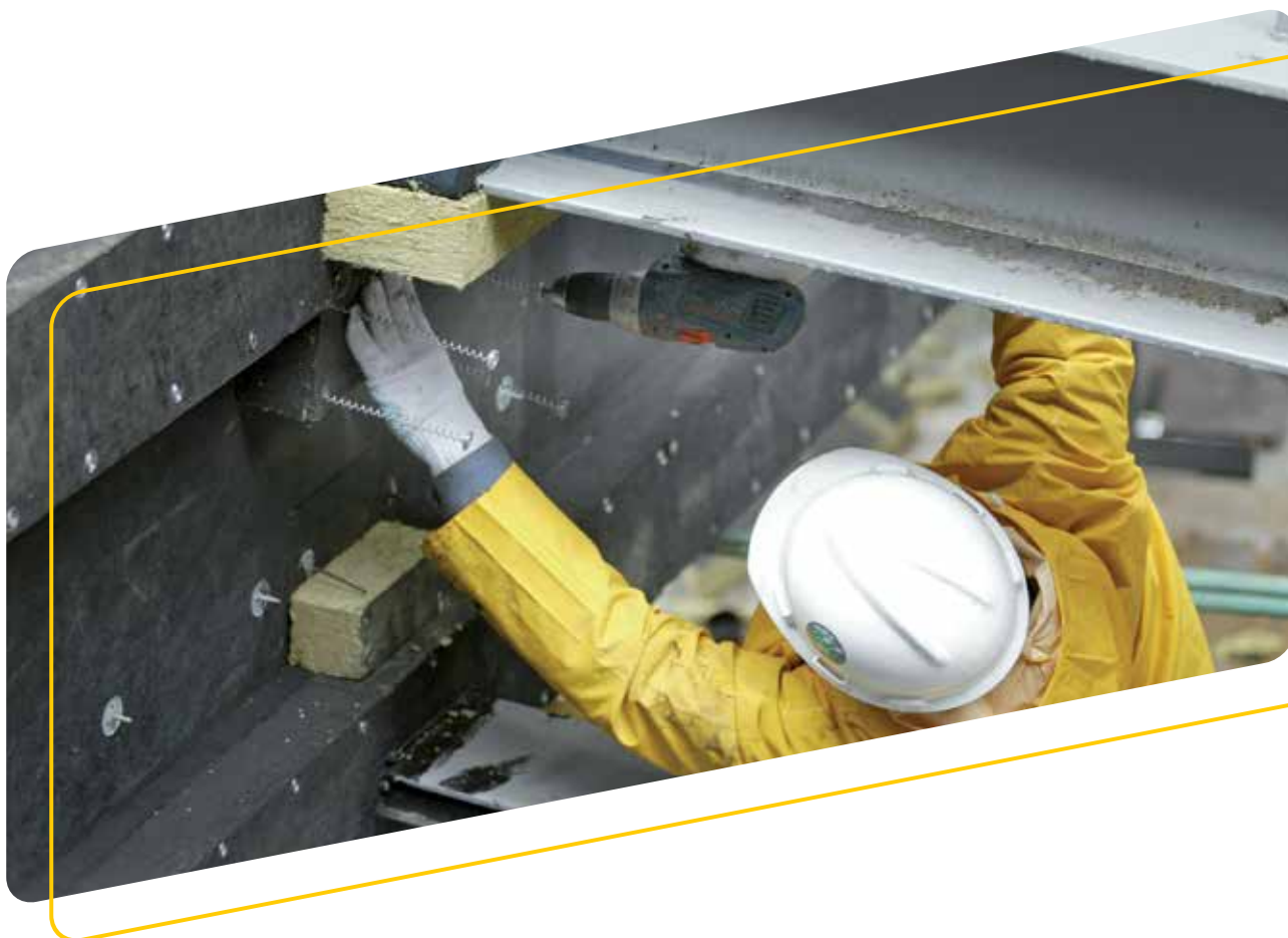
Fig. 4 Fixarea Isover FireProtect* cu știfturi (pini)
